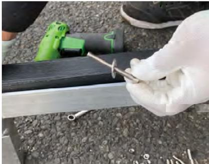
ボルト、ワッシャ、ナットを使用し、アルミトップレールとプラウッドを固定してください。
